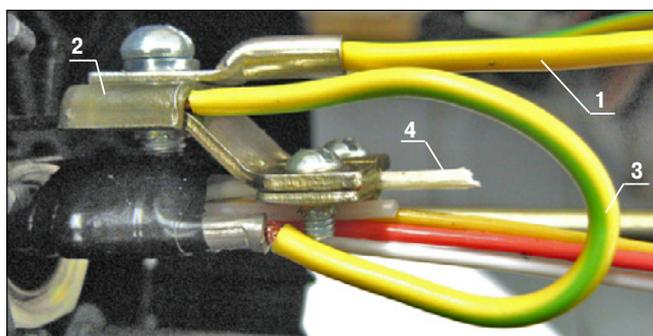
1 – перемычка электрического соединения вводимых ОК;
